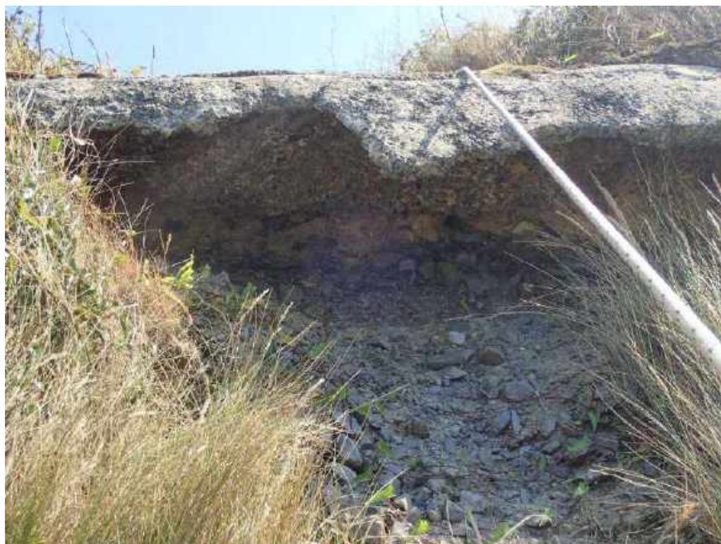
Figure 13 : Remblais anciens (fossé béton) au profil 7C
