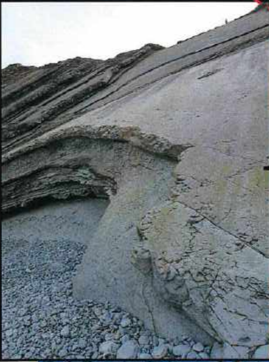
Dalles bréchiques/fracturées avec écoulements d'écaillies et bombement/décollement en butée latérale du sous-cavage (Cerema 02-2021)
