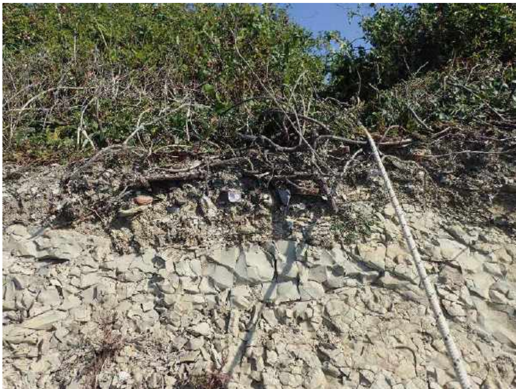
Figure 12: Remblais récents au profil 9A
