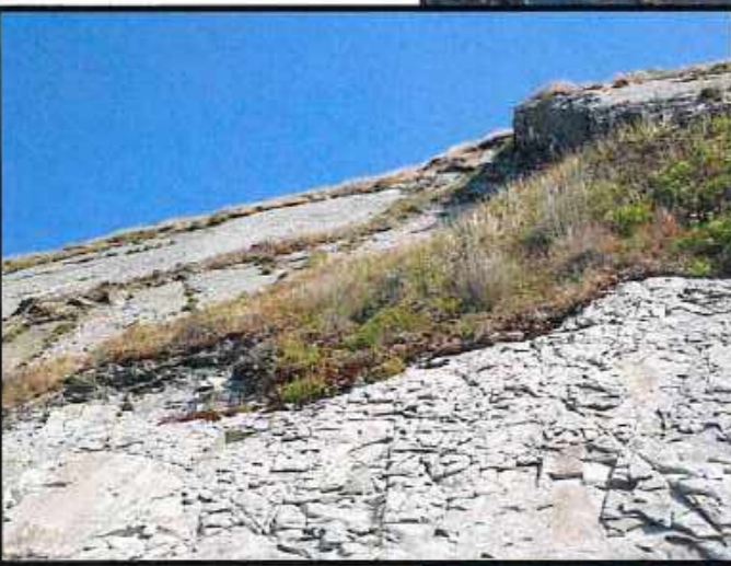
Eroulement de dalles (dessous A) en cours avec broyage latéral (Cerema 07-2020)
