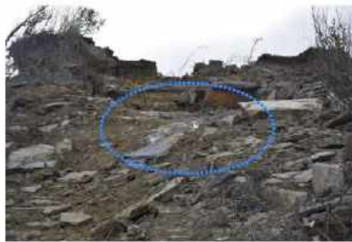
Arrivée d'eau ponctuelle sur la bordure est du glissement
