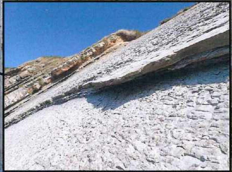
Dalles fracturées Ecoulements d'écaillies et décollements de dalles sur joints marneux (Cerema 07-2020)
