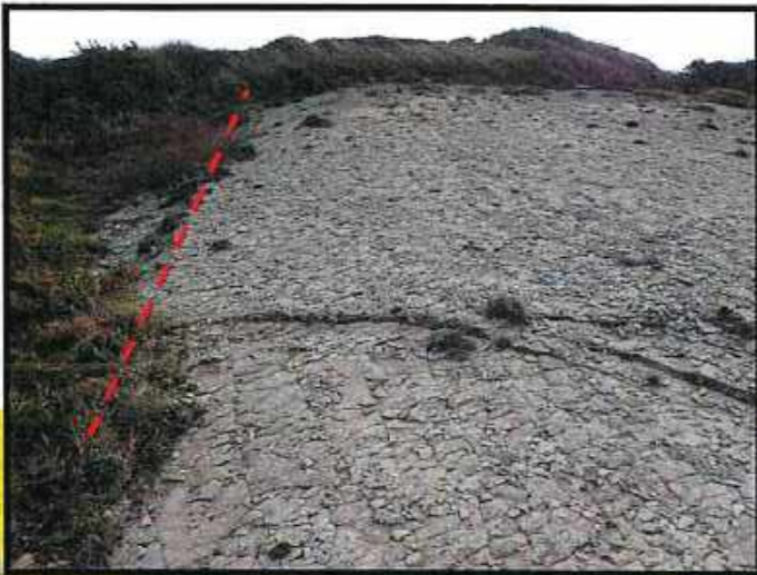
Dalle fracturée/décollée et glissements superficiels (Cerema 02-2021)
