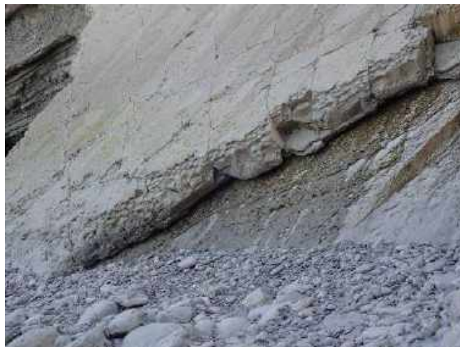
Figure 19 : Exemple de suintements d'eau en pied de falaise (profil 9A)
